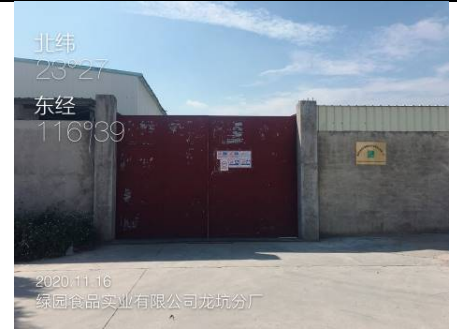
Factory gate 工厂大门
